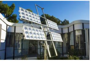
Le caractère innovant de la solution ECHY réside dans l'apport de lumière naturelle au cœur même du bâtiment, là où la lumière du soleil n'était pas accessible. Le système se compose de trois éléments principaux : les capteurs, le transport de lumière et le luminaire :
